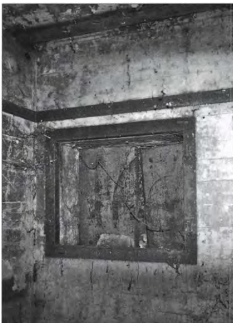
Boven op de linkerpagina een foto van de gang met de kamers. Eronder de in de bunker nog aanwezige elektrakasten. Rechts in beeld is nog net de binnenste gasdichte deur van de noordelijke gassluis zichtbaar. Op de foto rechts het 'venster' in de westwand, dat uitziet op de achtertuin van de Juliana van Stolbergstraat nummer 5. (foto's: R. Vosseveld)
